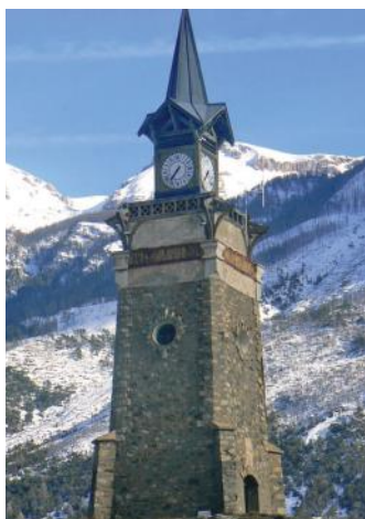
▲ Fig. 2 : La Tour des Hermès à L'Argentière.
