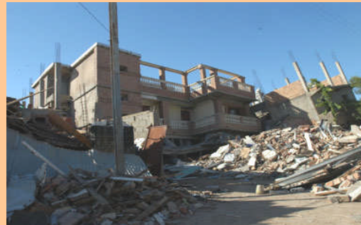
Le soir du 21 mai 2003, Alger et ses environs ont été frappés du plus fort séisme que le pays ait connu en 23 ans. Plus de 2000 personnes ont été tuées et 9000 autres sont blessées. La Wilaya de Boumerdes est la plus touchée.
