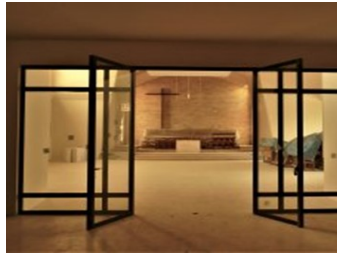
Nouvelle entrée de l'église
