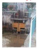
Le système de vidange de l'égayoir est désormais opérationnel avec le. changement de la trappe et la remise en état mécanisme d'ouverture. La dernière opération travaux programmés (avant fin 2016) consistera en la réparation du plancher et
