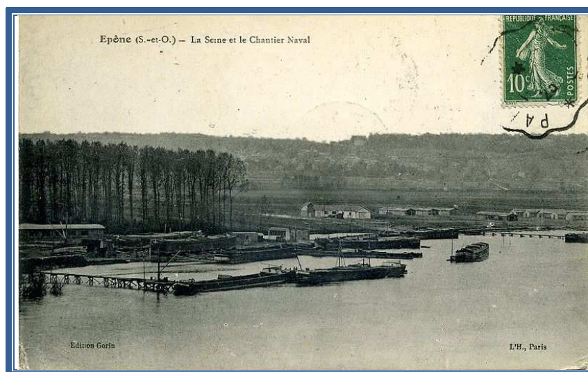
Chantiers navals d'EPONE en bordure de Seine
