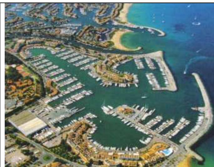
Cette cité lacustre, construite dans les années 1970, a été édifiée dans une ancienne zone humide au fond du golfe de Saint-Tropez.
